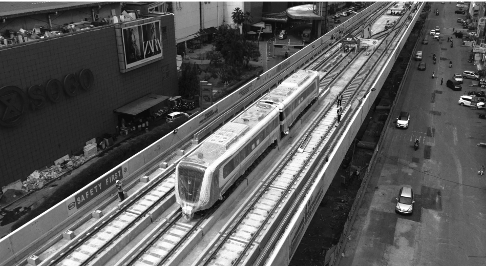
Foto udara gerbong kereta "light rail transit" (LRT) berada di jalur simpan "section" 5A di Kelapa Gading, Jakarta, Minggu (15/4). Setelah diangkut dari Pelabuhan Tanjung Priok pada Sabtu (14/4) malam, gerbong LRT untuk rute Kelapa Gading-Velodrome diangkat ke lintasannya atau "pocket track" untuk segera dilakukan penyambungan serta instalasi sembari menunggu selesainya pembangunan depo LRT Kelapa Gading.
